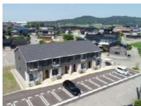
【令和元年度建設】 小川地内：1棟・4戸
