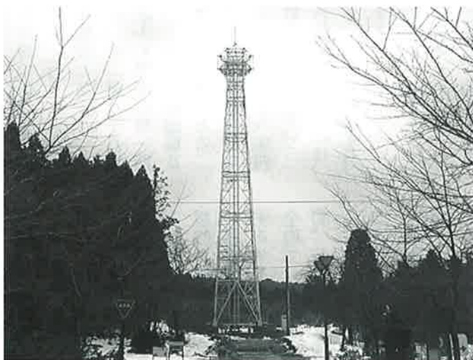
石坂地区の移動通信用鉄塔施設
