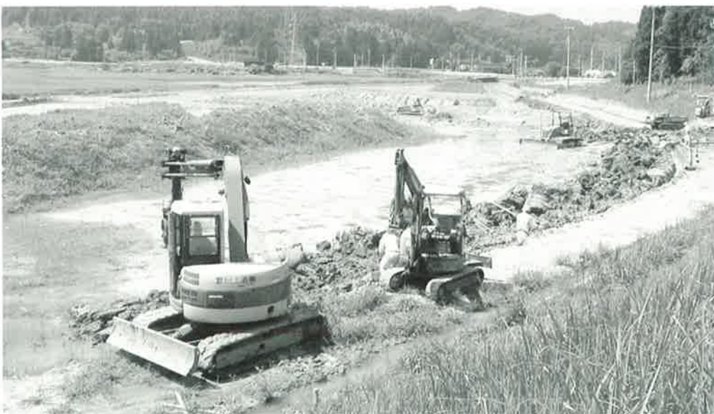
中山間地域総合整備事業 石坂地区
