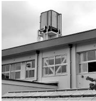
宝達小学校の高架水槽
