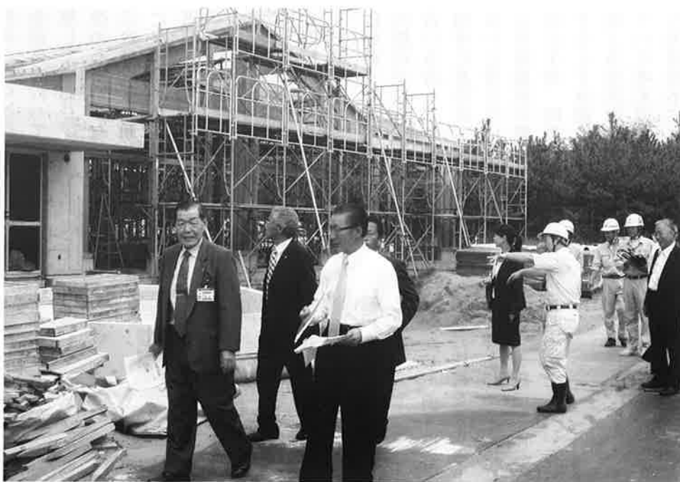
建設中の相見保育所を現地視察する教育厚生常任委員会。
