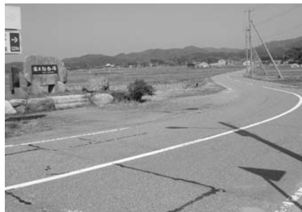
町道に認定された上田10号線
