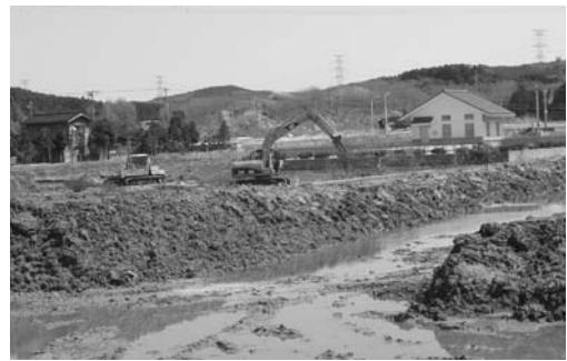
県営事業(散田地区のほ場整備)
