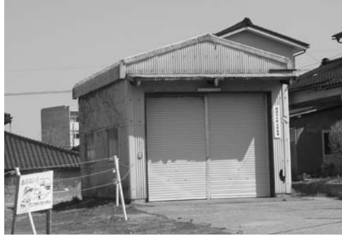
小川会館近くにある水防倉庫
