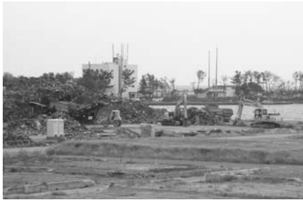
名取市閑上での復旧作業
