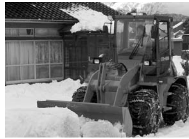
12月の積雪による除雪作業
