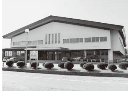
耐震補強工事が行われる 押水総合体育館
