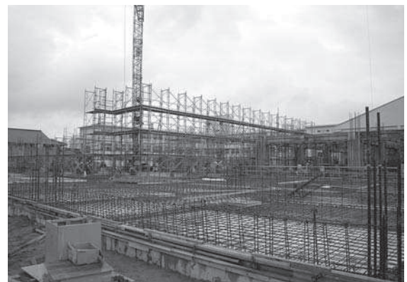
建設中の宝達中学校
