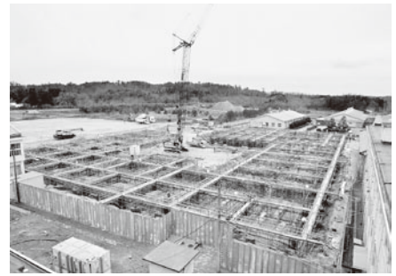
建設中の宝達中学校
