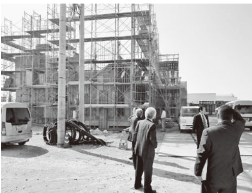
建設中の「ティアラみね尊館」を視察
