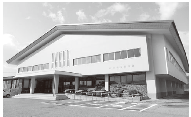
押水総合体育館
