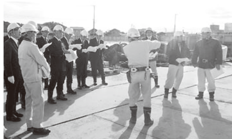
新病院建設現場の視察を行う病院運営特別委員会
