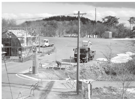
山頂公園駐車場を整備
