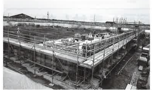
新病院の建設工事現場
