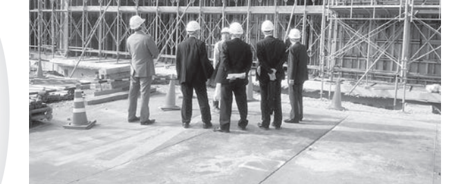
新病院の建設工事現場視察
