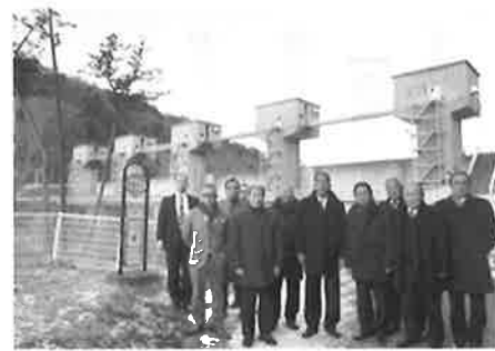
(津波を防いだ普代村の防潮堤)
