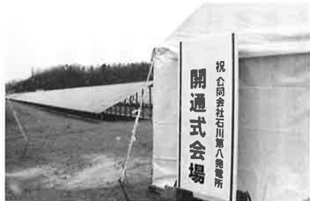
(太陽光発電が始まった石川第八発電所)
