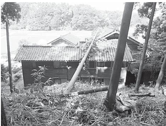
(県単荒廃地復旧事業箇所〔荻谷地区〕)
