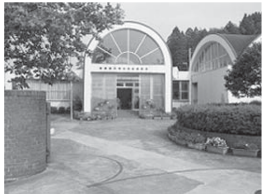
▲改修が進められる中央保育所
