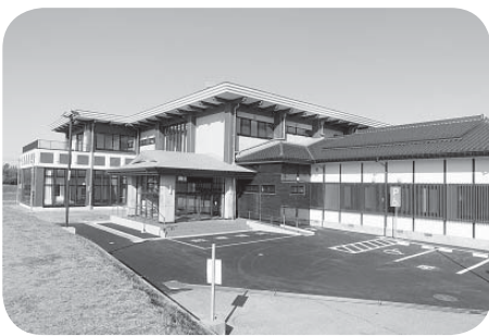
▲完成した武道館
