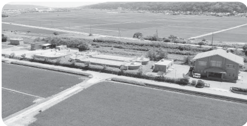
▲下水道志雄処理場
