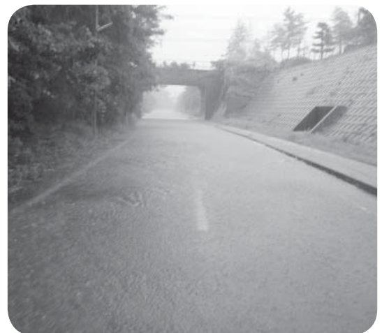
▲冠水した町道
