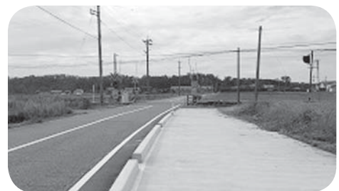
▲完成した踏切前の歩道
