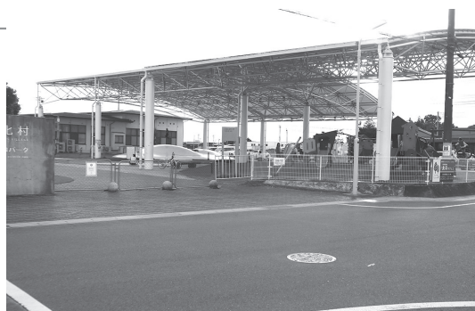
茨城県境町の屋根を設置した野外遊び場
