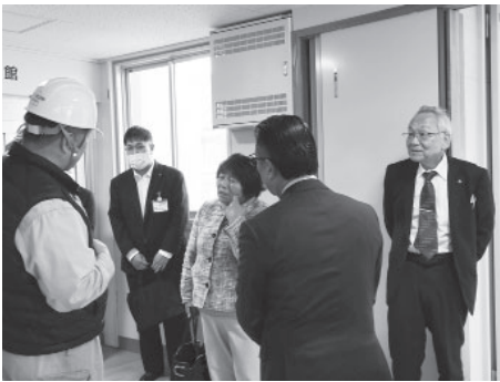
小学校体育館の空調設備を視察
