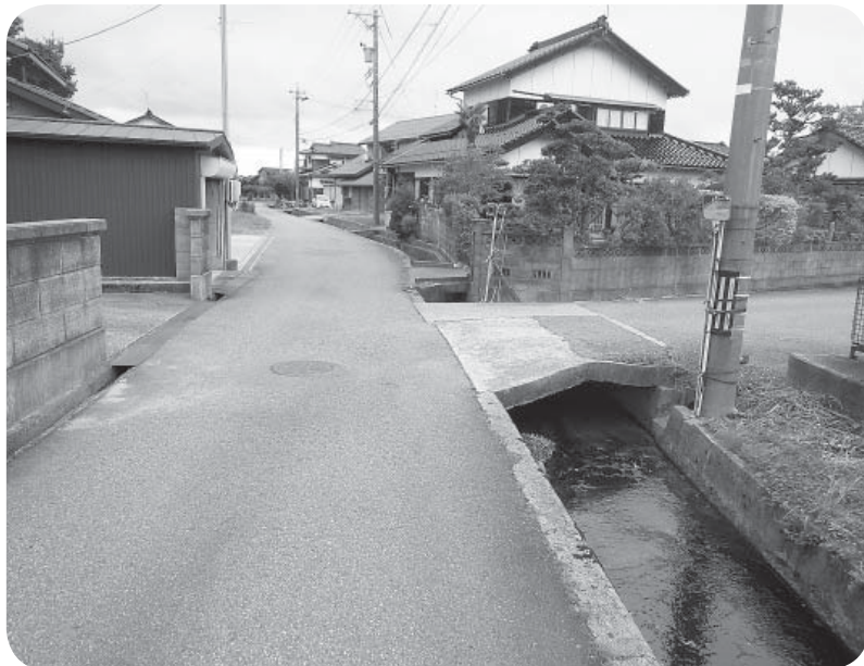
▲町道付帯水路の現状
