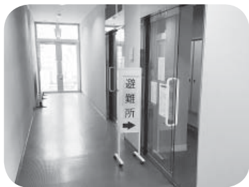
▲大雨時の避難所開設 (さくらドーム21)
