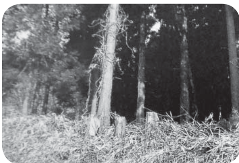
▲緩衝帯整備事業（東間地内）
