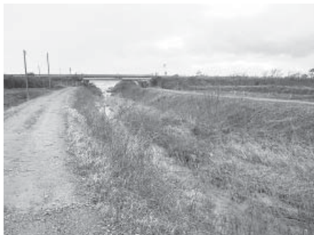
▲町道米出今浜線橋梁整備
