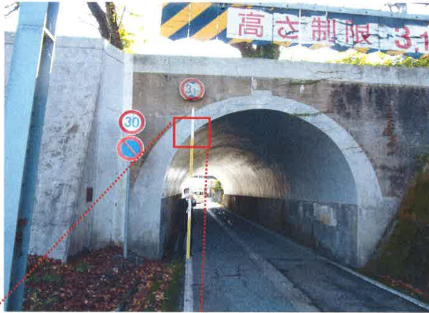
①トンネルの高さ（白線上）315cm
