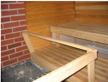
フィンランドといえば“サウナ” 集合住宅の地下に設置された 電気サウナ
