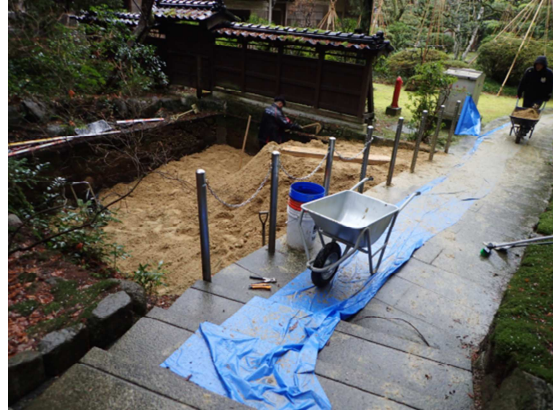
池の撤去工事の様子(12月)
