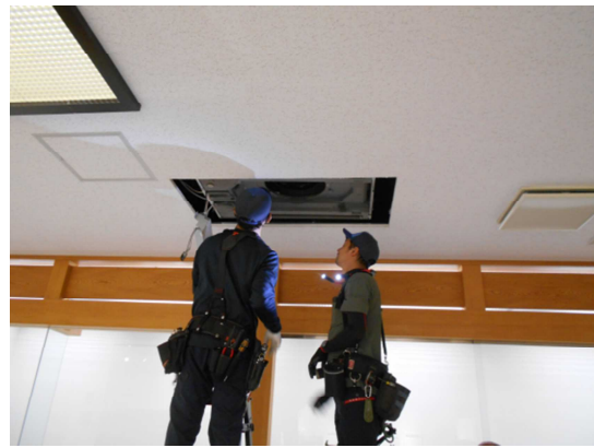
展示室の空調機修繕の様子(10月)
