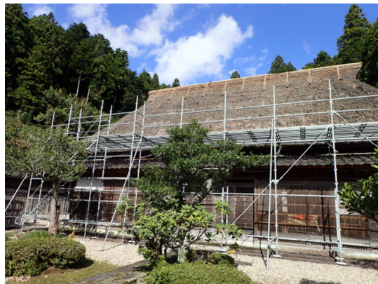
茅葺屋根修繕工事の様子(11 月)
