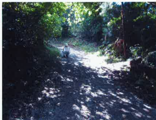
虎口作業道補修 下部
