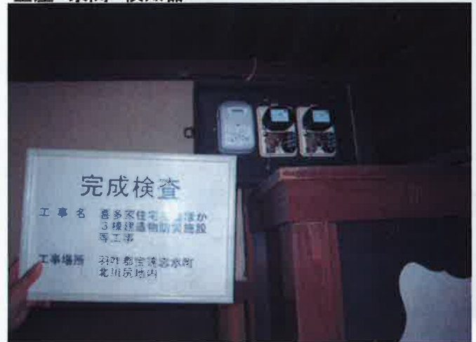
主屋 京間 検知器
