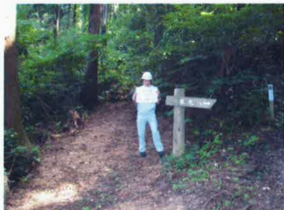
小丸山門の崩壊した土砂撤去
