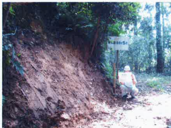
小丸山門の崩壊した土砂撤去
