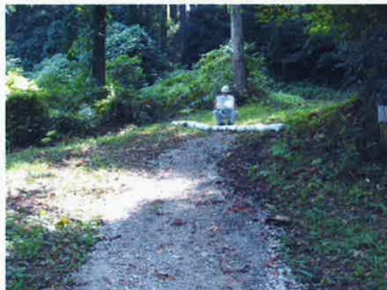
虎口作業道補修 上部
