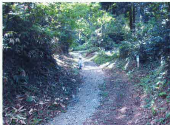
虎口作業道補修 中腹部
