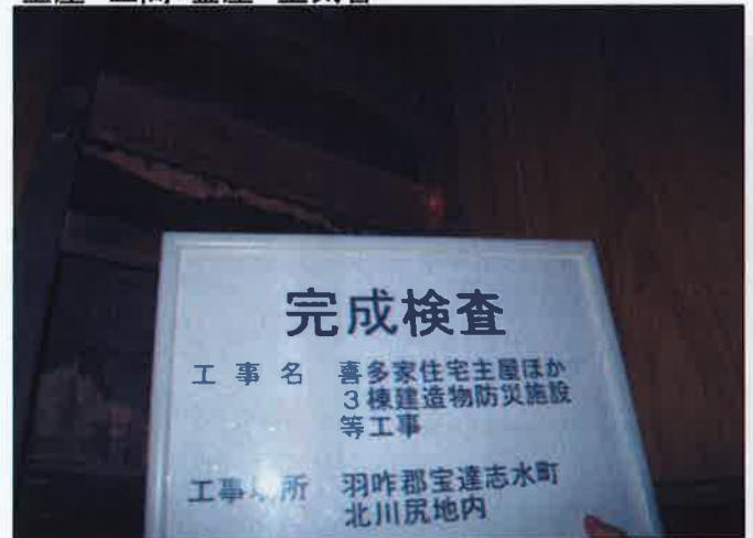
主屋 土間・釜屋 空気管
