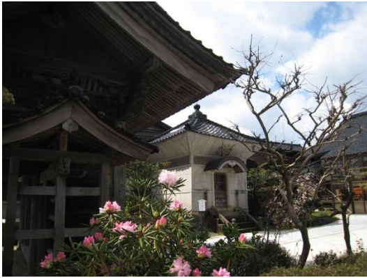
〔写真〕 覚正寺「経蔵」 屋根修理に対する町補助事業の実施
