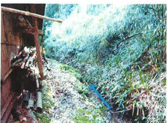
写真7 法尻に施工される水路(素掘り)の状況
