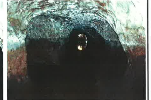
写真37 洞穴から入口方向を望む。
