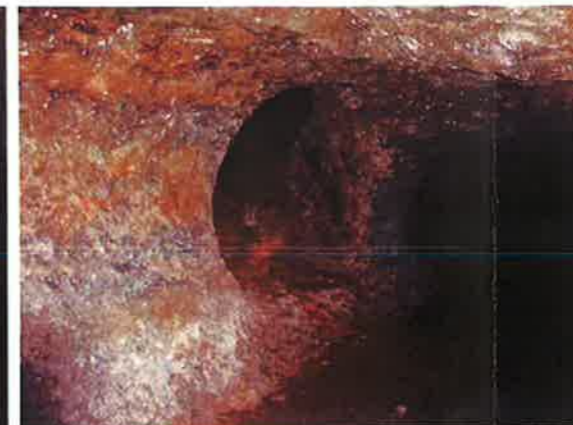
写真51 2本の洞穴は、3m程度ごとに横断穴がある。
