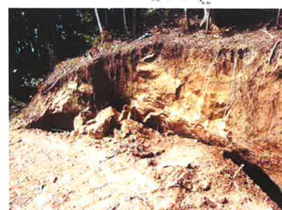
写真13 滑落崖の状況。斜面内の洞穴は崩落している。
