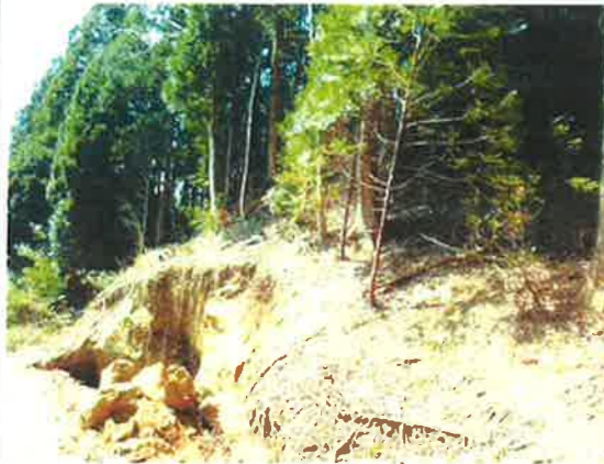
写真16 滑落崖の状況(斜面東側から望む)
