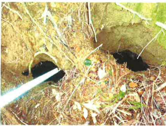
写真21 斜面上部に見られる陥没穴の状況
