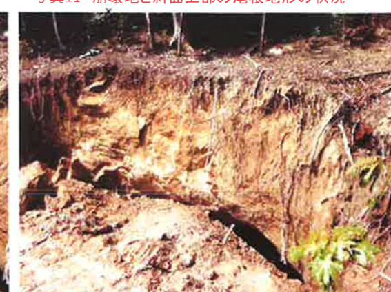
写真14 滑落崖の状況。斜面内の洞穴は崩落している。
