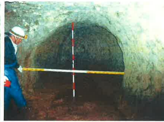
写真31 洞穴の状況。高さは約1.9m、幅は約2.5m
