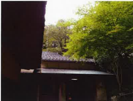
喜多家 屋根清掃 (管理棟・資料館・屋外トイレ)
