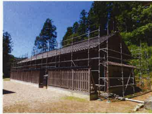
岡部家 納屋屋根修繕工事
