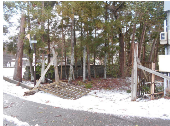
喜多家暴風雪による被害 門扉の破損
