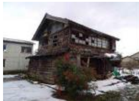
倒壊の恐れがある空き家(出典: 国土交通省HP)
